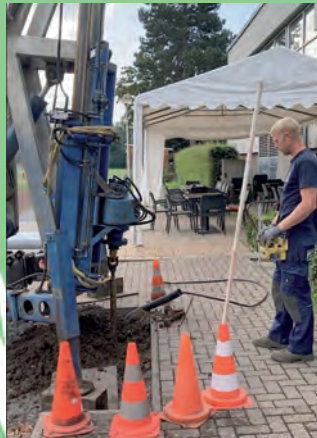
Bohrgerät in der Vorbereitung
