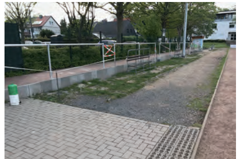
Die Tribüne wartet auf ihre Fertigstellung
