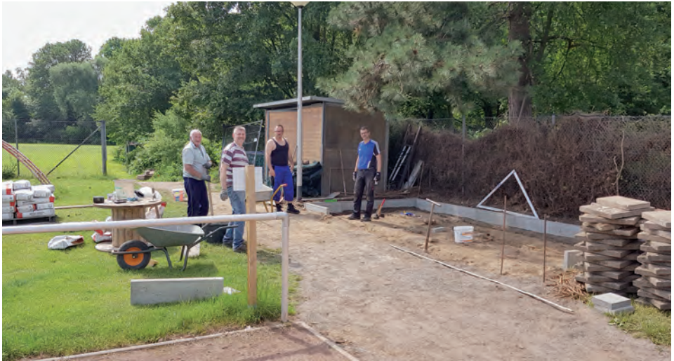
Fleißige Helfer setzen die Bodenplatte für die neue Materialhütte
